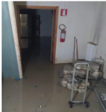
Il piano interrato del centro diurno Cimatti, in via Pantoli
